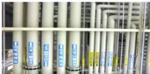
製程廢水及廢液分流收集管線
